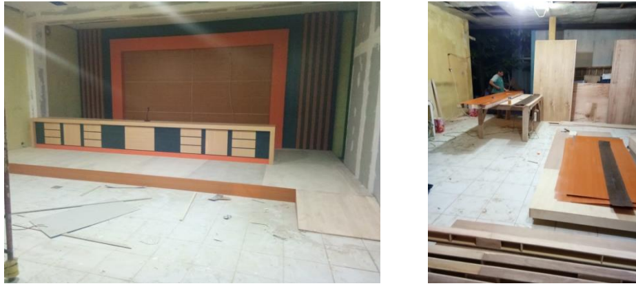
Gambar 3.3 Renovasi Aula KPU Kabupaten Tangerang
